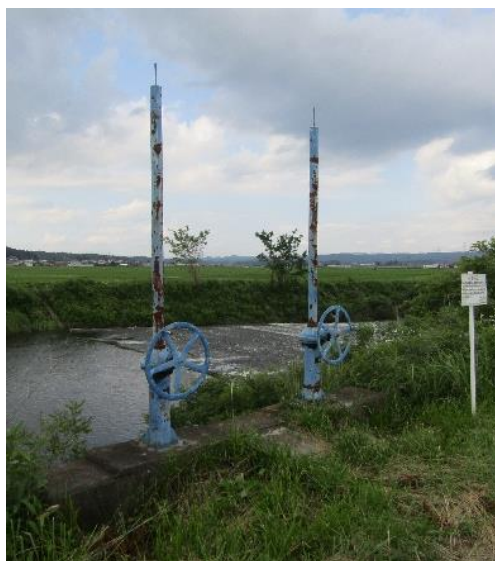
現在の玉野堀水門
