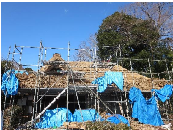
八槻家住宅屋根修理
