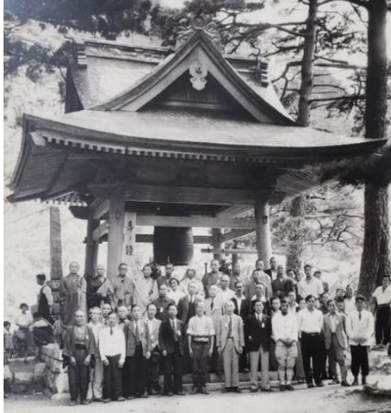
昭和 24 年（1949）改築工事完成時の鐘楼堂
