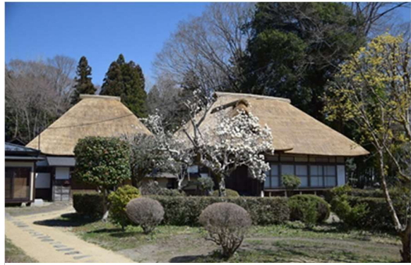
八槻家住宅主屋棟と書院棟
