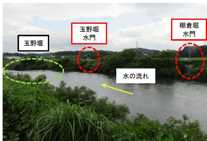
現在の玉野堰と棚倉堀・玉野堀の水門
