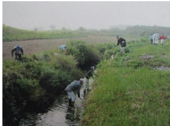
棚倉堀の清掃作業
