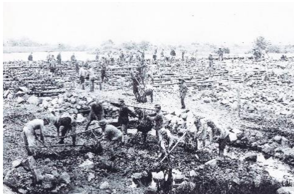
玉野堰の改修工事の様子
