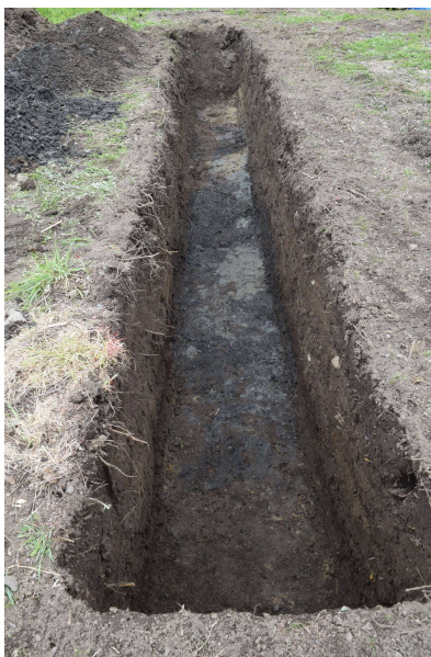
赤館城跡試掘調査の様子
