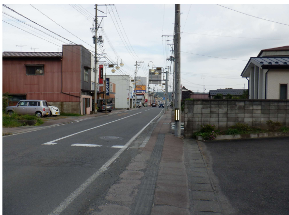
現在の棚倉城下道路街路灯
