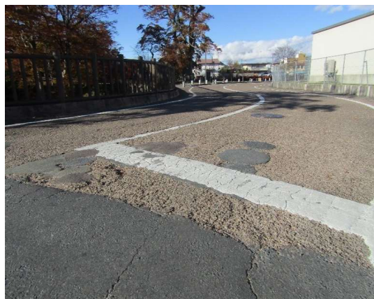
現在の棚倉城跡周辺道路
