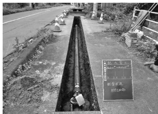
水道管布設替工事の現場
