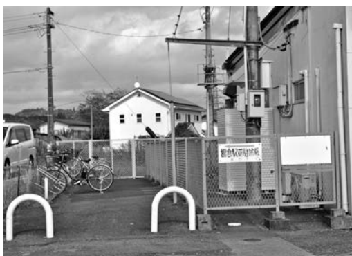
屋根の設置を望む駐輪場
