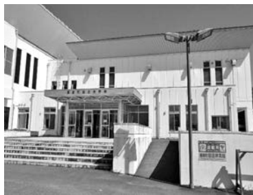
エアコンの設置が望まれる避難所
