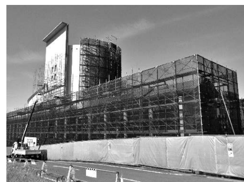
大規模改修工事中の文化センター
