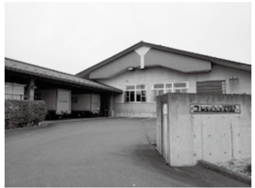
柵倉町学校給食センター
