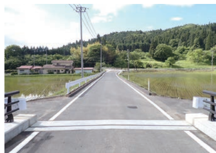
道路改良を行った町道
