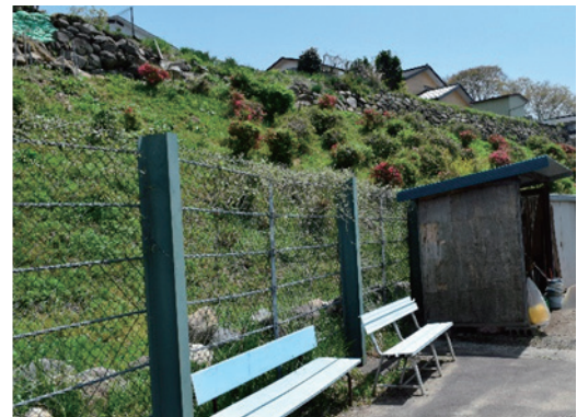
防護フェンスによる崩落防止措置
