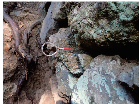
目地の隙間を計測
