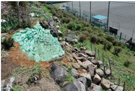
土嚢による崩落防止措置
