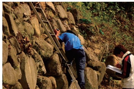
二ノ丸石垣材質調査
