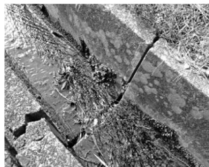
老朽化により補修が必要な用水路
