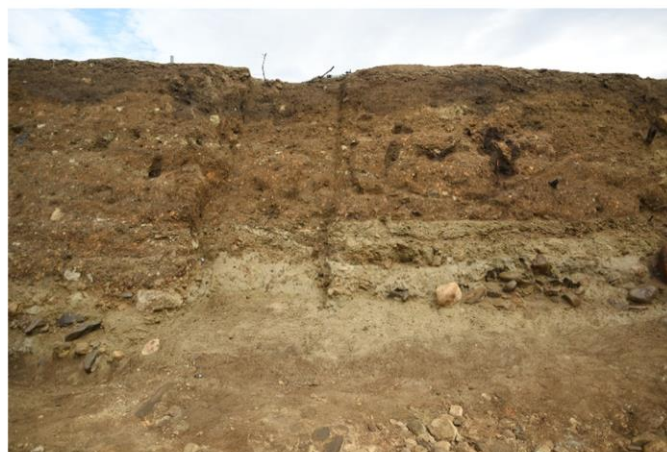
石垣背面の盛土
