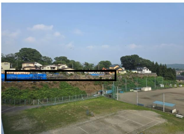
石垣遠景(枠内が解体範囲)
