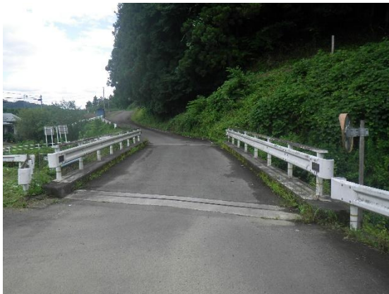
地域住民の協力を得て橋面の堆積土砂を撤去した例
