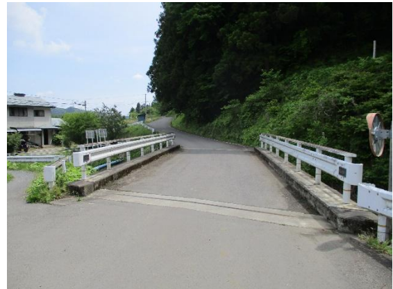
地域住民の協力を得て橋面の堆積土砂を撤去した例
