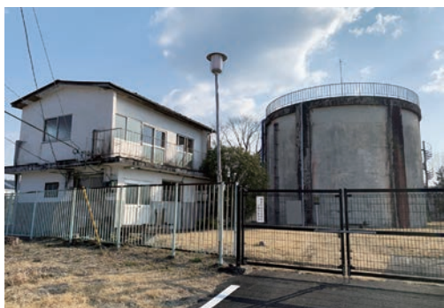
上水道施設の八幡沢配水池
