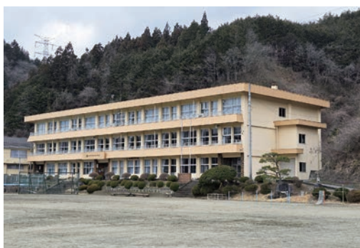
棚倉中学校分教室が入る 旧高野小学校校舎
