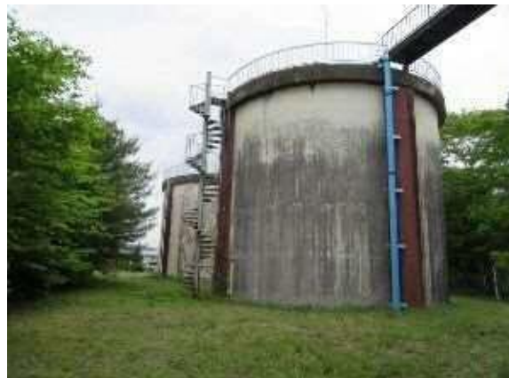
「八幡沢第2配水池」
