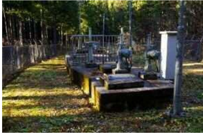
「瀬ヶ野水源施設」
