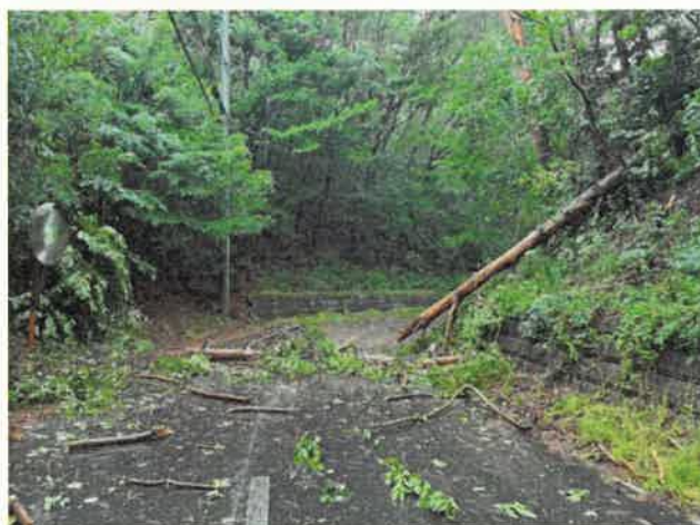
倒木した樹木破片が路上に散乱した状況
