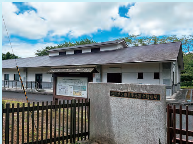
逆川地区農業集落排水処理場
