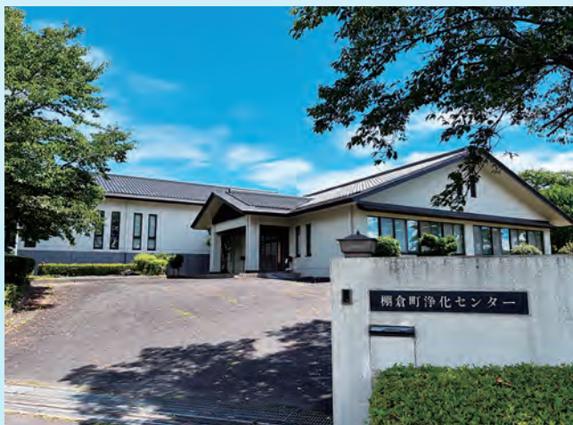
棚倉町浄化センター
